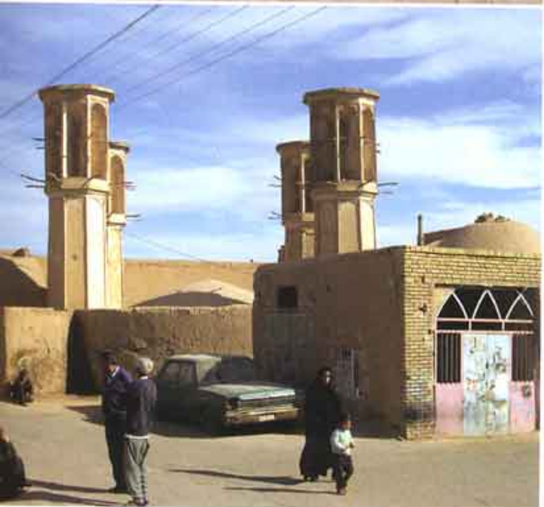
Chaque quartier du centre ancien dispose d'un réservoir d'eau (Abambar) qui approvisionnait en eau potable les habitants.
